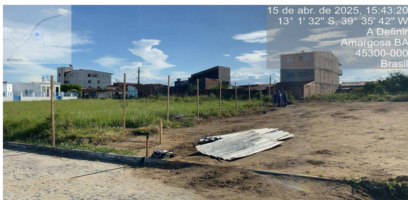
Foto 02: Início do fechamento com telhas metálicas
