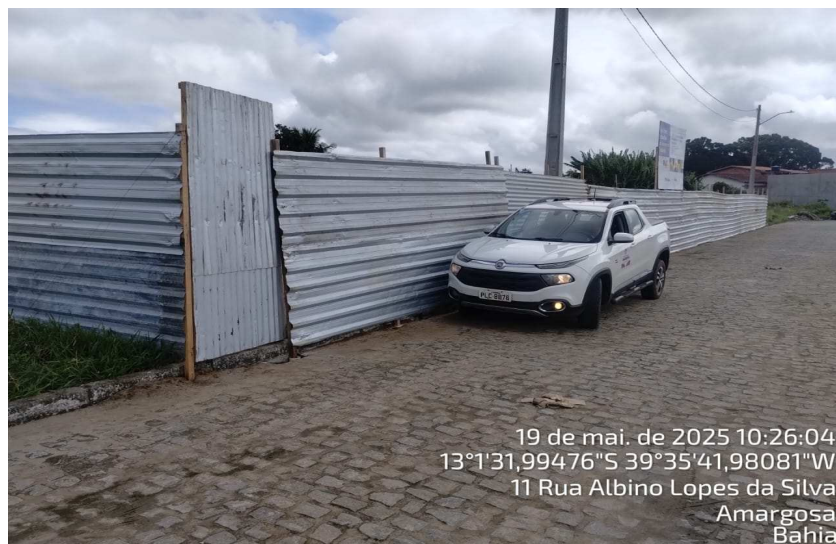
Foto 06: Obra sem efetivo
