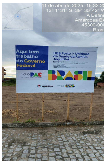
Foto 01: Instalação da placa de obra
