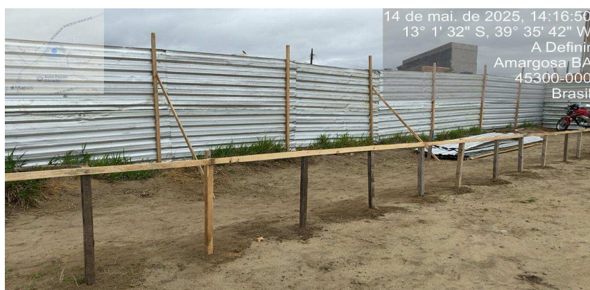
Foto 05: Execução do gabarito
