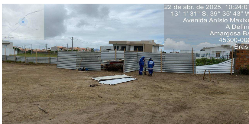
Foto 03: Construção do barracão
