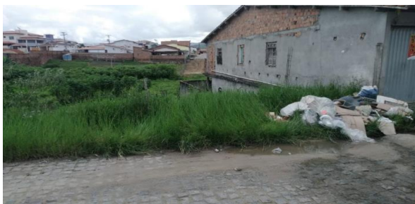
Rua Vale do satélite: vulnerabilidade social - risco de deslizamento
