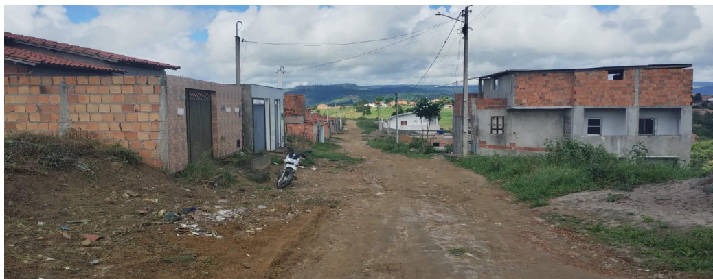
Rua sem pavimentação
