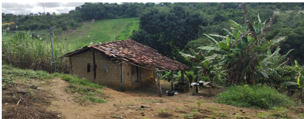
Acesso ao território necessitando adentrar espaços com mata
