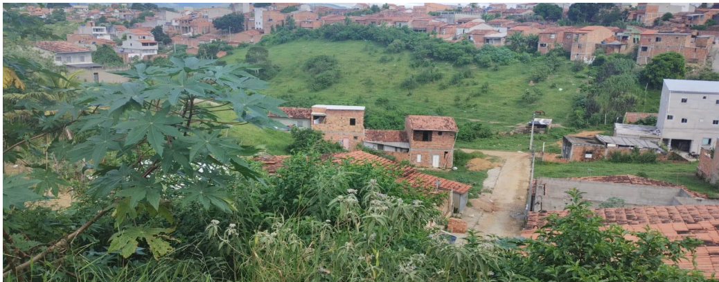
Rua sem pavimentação
